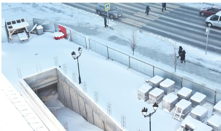
менской подземки на сумму 60 миллионов рублей. Проект предусматривал демонтаж старых лестничных маршей, устройство основания и сооружение нового монолитного лестничного марша, ремонт потолка, стен, пола, устройство систем коммуникации и водоотведения. Поначалу рабочие дружно взялись за
